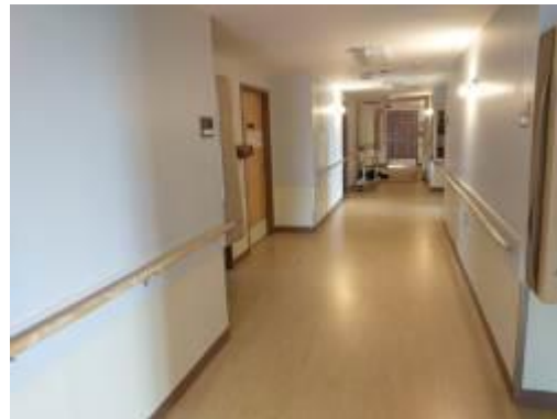
四樓走廊新油漆
