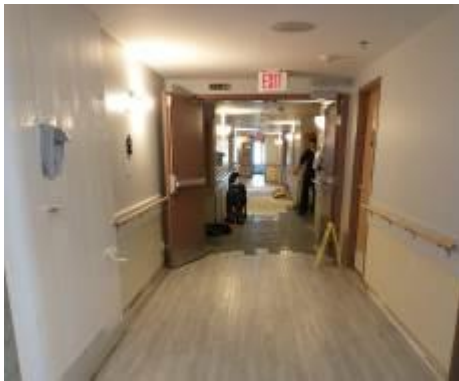
三樓走廊重鋪地板
